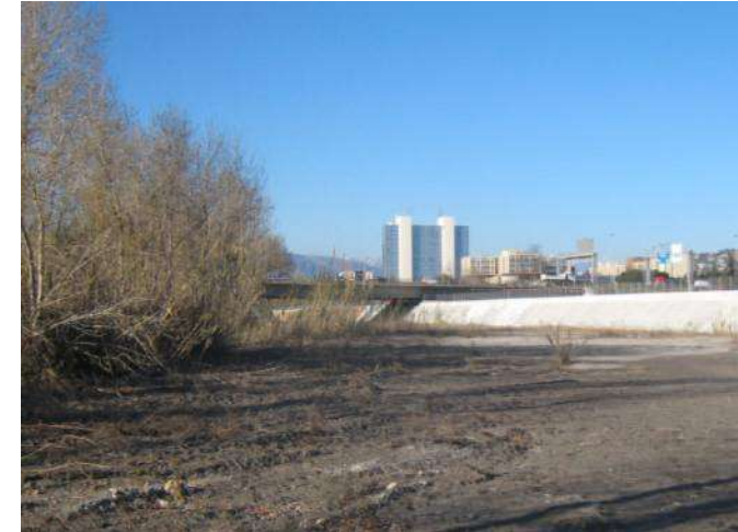
Figure 46 : Vue du CADAM depuis les berges du Var (photographie Egis France)
