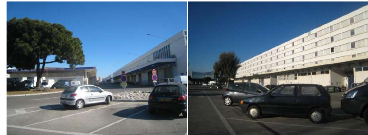
Figure 93 : places de stationnement dans l'enceinte du MIN (photo Egis France)
