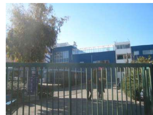
Figure 56 : Institut de formation automobile de Nice (photographie Egis France)
