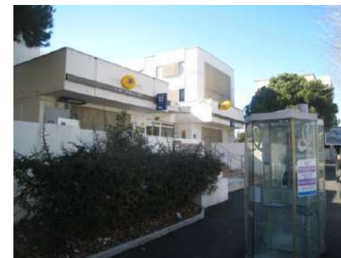
Figure 55 : Bureau de Poste (photo Egis France)
