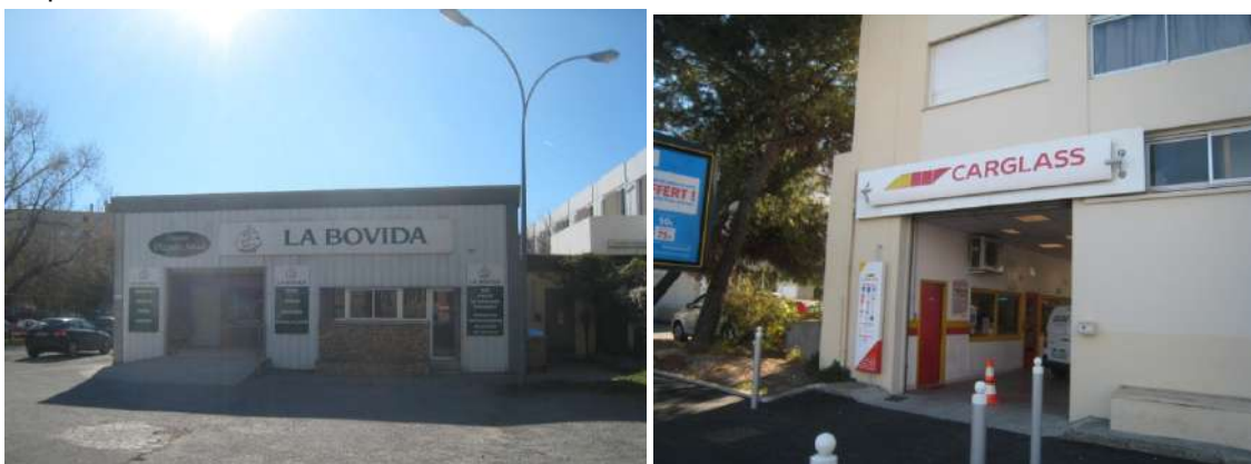
Figure 8 : Photo des magasins La Bovida et Carglass (Source : Egis France)
