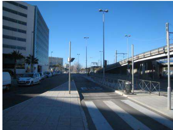
Figure 44 : Boulevard René Cassin avec le quartier d'affaires de l'Arénas à gauche (photographie Egis France)
