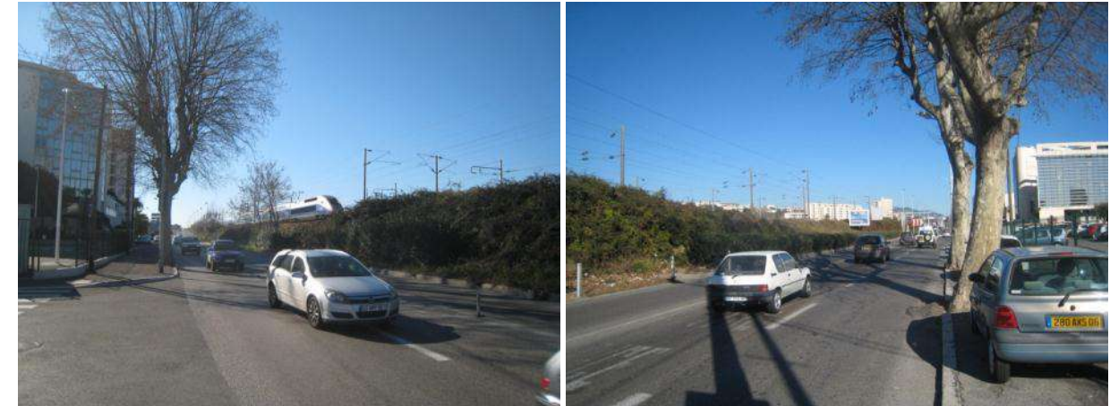
Figure 74 - Talus de la voie ferrée surplombant le Boulevard Cassin (Source : EGIS France)
