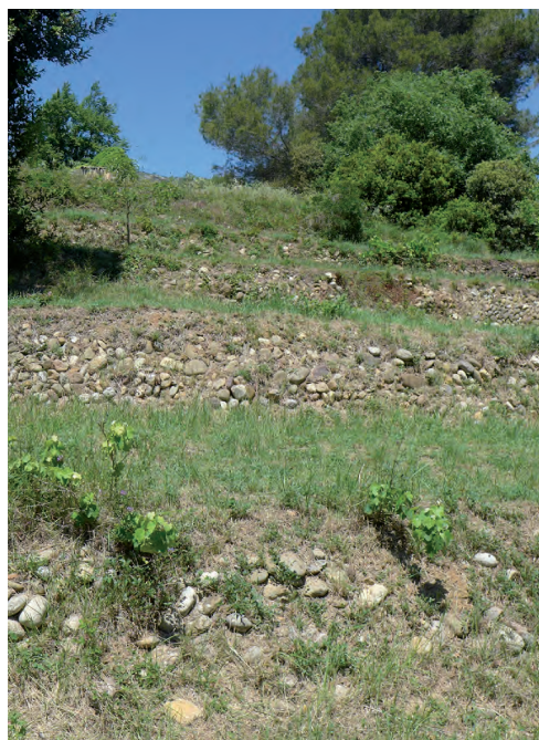
reste de restanques abandonnées
