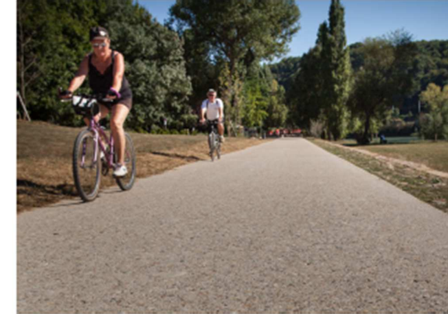
Figure 25 : Béton coulé en place, traitement de surface : bouchardé
