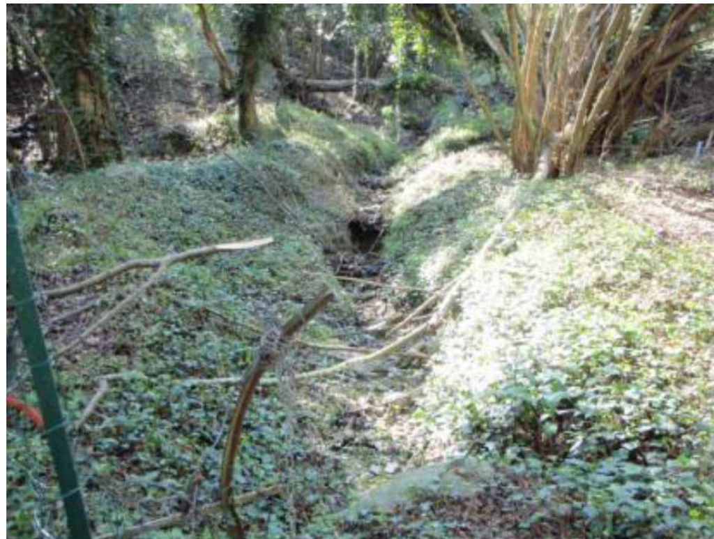
Figure 44 : Vue vers l'amont du vallon depuis la buse (ARTELIA)
