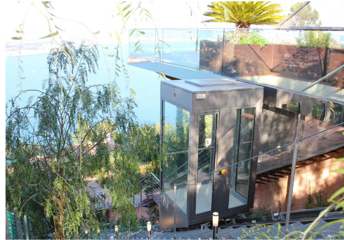
Figure 19 : Principe de transport collectif, exemple d'ascenseurs extérieurs
