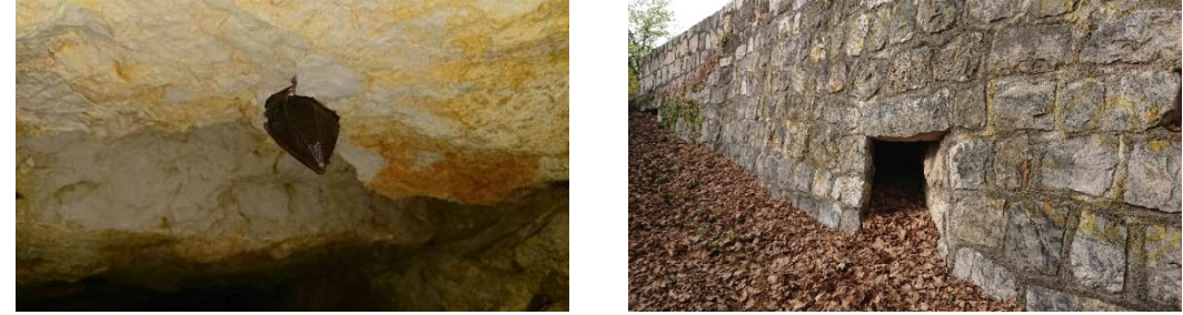
Photo 5 : Localisation du tunnel sous la route et Petit Rhinolophe présent à l'intérieur
