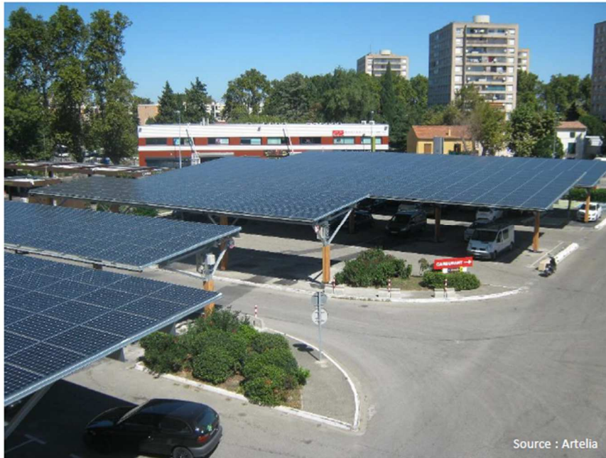
Figure 119 : Exemple de panneaux photovoltaïques en ombrière sur parking
