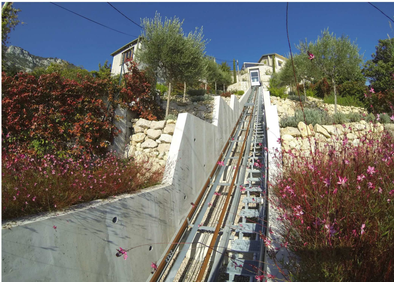
Figure 13 : Exemple de desserte utilisant un ascenseur oblique (source : Alfred Peter paysagiste-urbaniste | ARTELIA | Adéquation)
