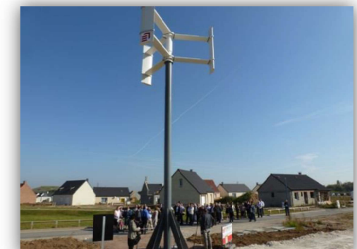
Éolienne à axe vertical, écoquartier de la Marlière (Courcelle-lès-Lens)
