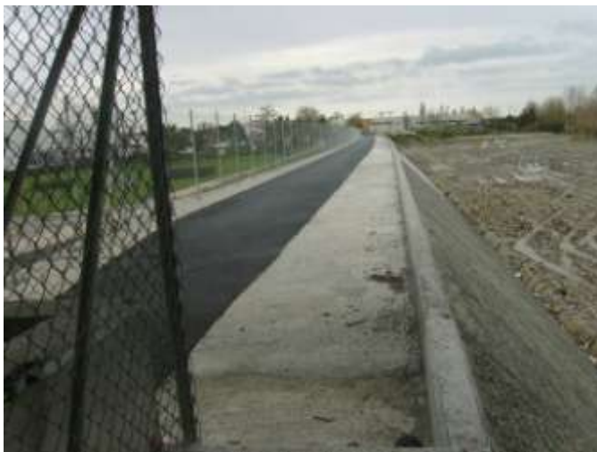
La digue des Français au niveau du MIN en aval immédiat de l'ouvrage autoroutier
