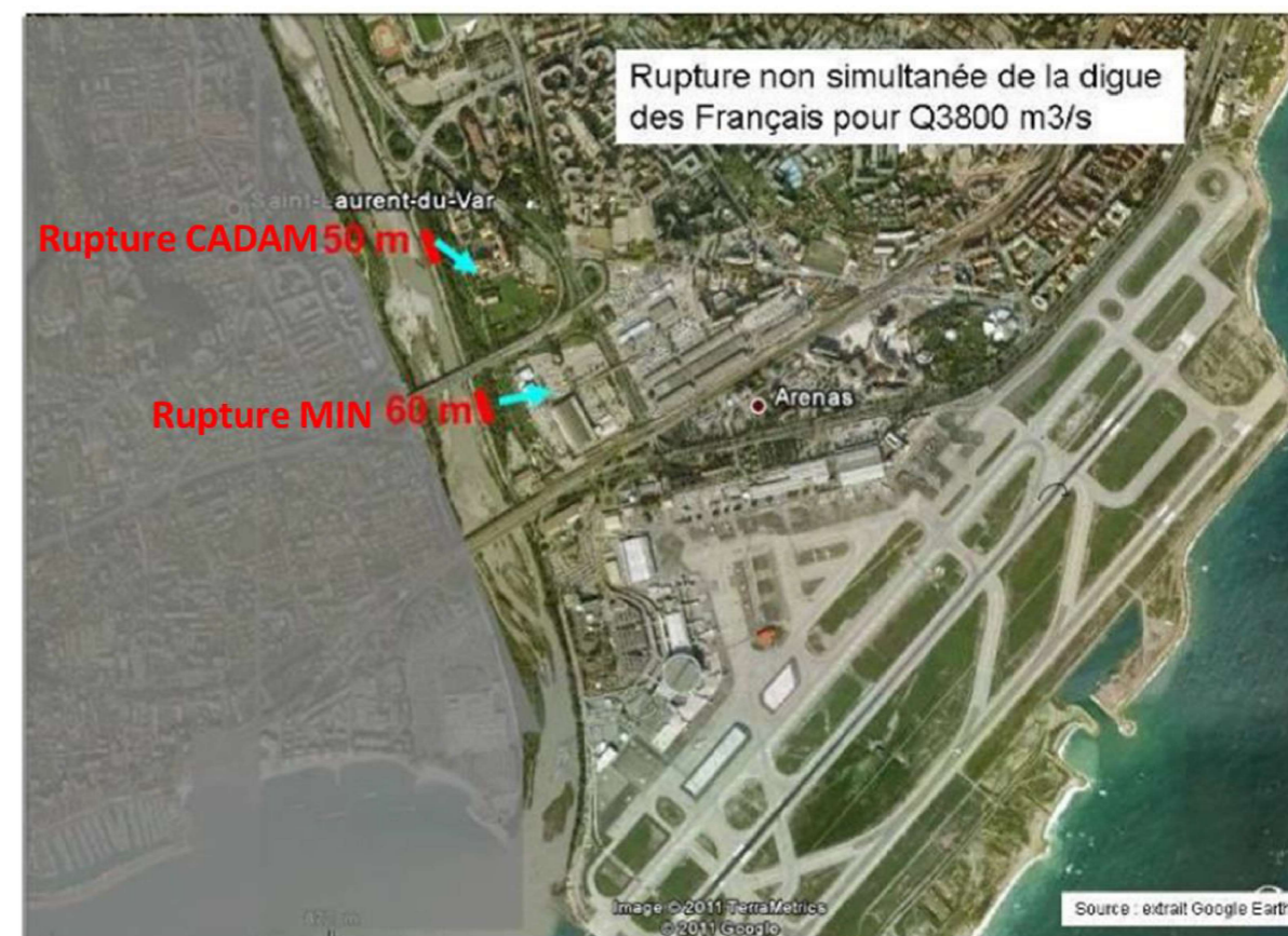
Figure 3 : localisation des ruptures de digue des Français
